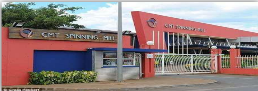
Head Office of Compagnie Mauricienne de Textile Ltée in Mauritius
